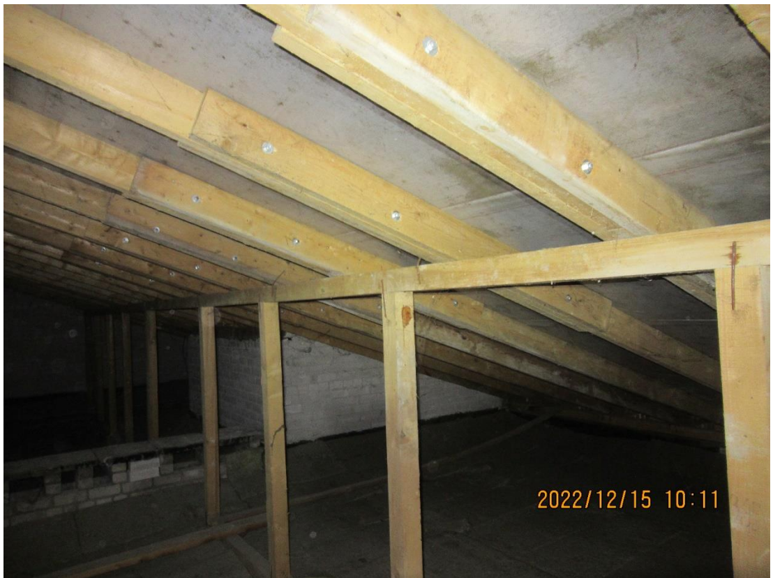
Nuotrauka Nr. 2. Medinių stogo konstrukcijų vaizdas
