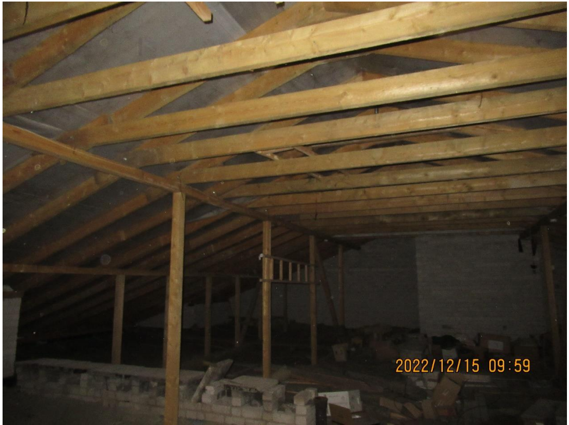
Nuotrauka Nr. 1. Medinių stogo konstrukcijų vaizdas
